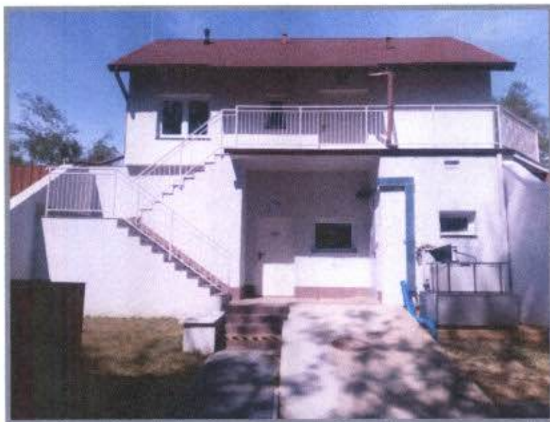
Oczyszczalnia ścieków w Magnuszewie
